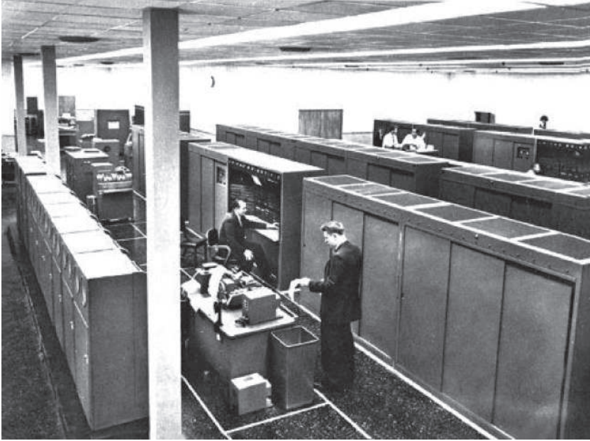
شكل ٩-٢: اليونيفاك نموذج ١١٠٣، الذي صُمم لإجراء العمليات الحسابية العلمية، والذي أعلنت عنه «ريمنجتون راند كوربورشن» في فبراير عام ١٩٥٣م.
