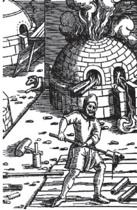
شكل ٨-٣: فرن عالٍ يعمل بالحطب من النوع الذي شاع استخدامه في أوروبا في القرن السادس عشر.
