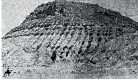
شكل ١-٣: قلعة الجندي، وتعرف أيضًا بقلعة الباشا.
