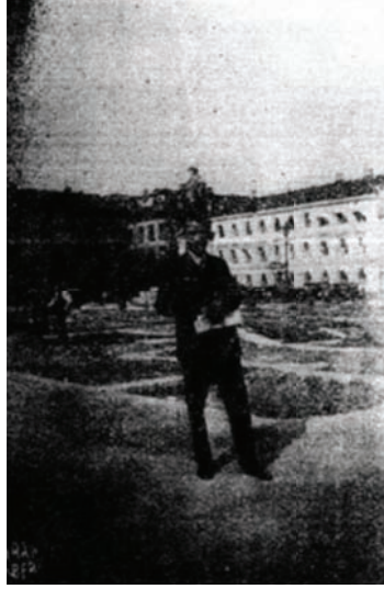
أمام تمثال جستاف أدلف بجوتنبرج.
