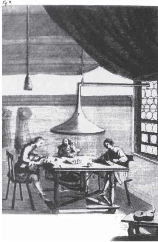
شكل ٤-١٣: تصنيع دُمى الزجاج الصغيرة بمساعدة منفاخ يدار بدواسة (من كتاب نوكل «أسلوب تجريبي في صناعة الزجاج» الصادر عام ١٦٧٩، بإذن من مؤسسة التراث الكيميائي).
