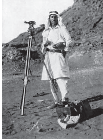
الرحالة يرصد الشمس بآلة التيودوليت.
